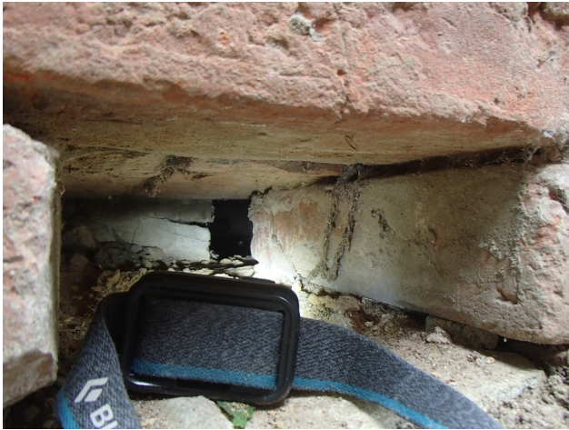
Fußboden: Untersuchung des Aufbaus der Holzbalkenkonstruktion
