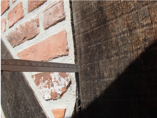
Außenwand: Vorsatzschale mit Fachwerk, dahinter Porotonstein
