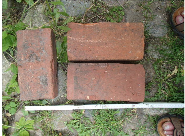
Außenwand: Abschätzung der Dicke des zweischaliges Mauerwerk
