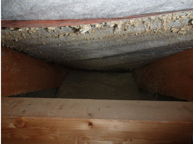
Dach: Dämmung der obersten Geschossdecke mit Zellulose
