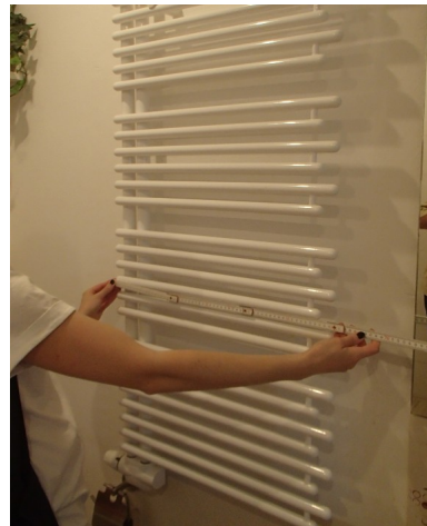
Heizkörper: Ausmessen fehlender Heizkörpermaße
