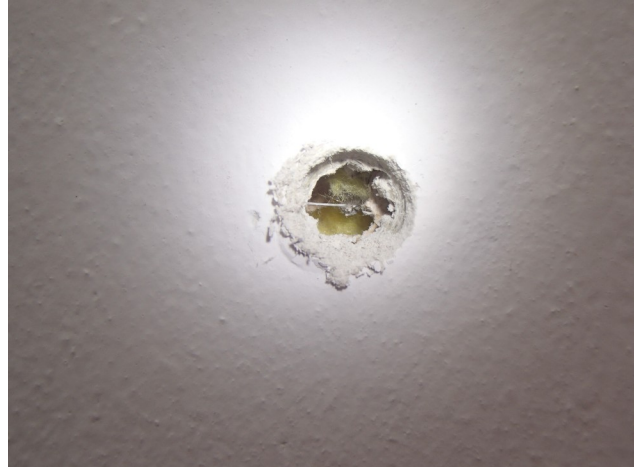
Dach: Überprüfung, ob vor der Dachdämmung eine luftdichte Ebene vorliegt, aufgrund lückenhafter Baubeschreibung
